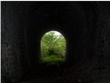
accès au tunnel abandonné 9997 tête du tunnel coté ouest la végétation a repris ses droits
