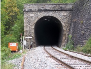
entrée du tunnel de Runac Berduquet longueur 968m
