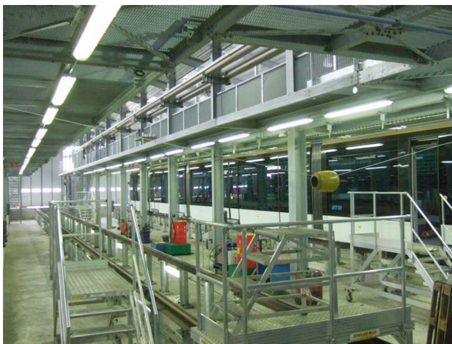
Voie sur fosse. Pour positionner exactement la rame au bon emplacement, le conducteur doit toucher le pot suspendu jaune foncé avec son parebrise.
