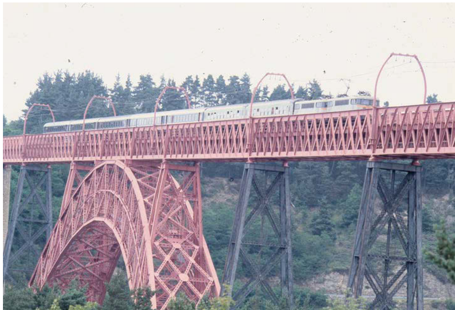
«L'Aubrac» sur le viaduc de Garabit en 1995 (Cliché J.P. Lasserre du Rozel)
