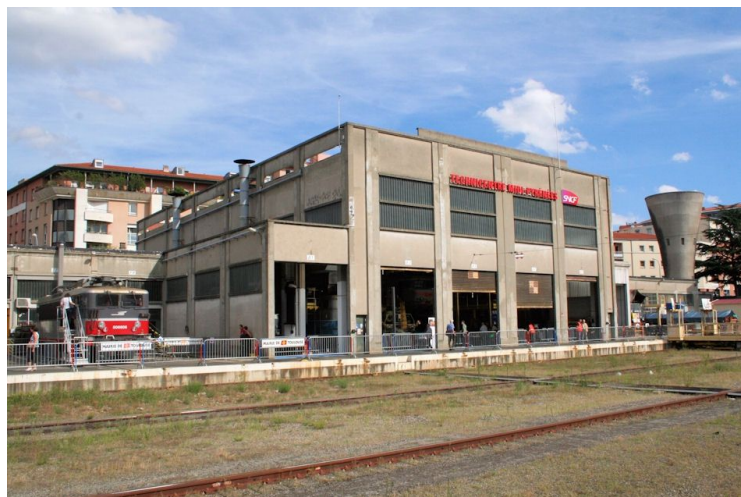
Dépôt de Périole
