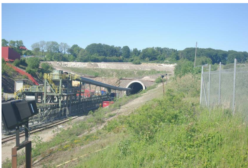
Le chantier vu de la plateforme ouverte au public.
