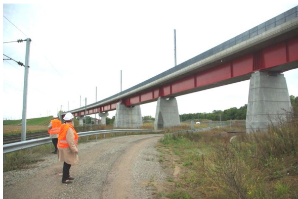
Ouvrage de franchissement des voies de la ligne actuelle Paris et Metz-Strasbourg
