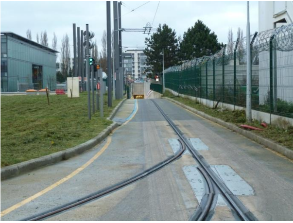
Débouché de la voie de raccordement à la ligne (G L)
