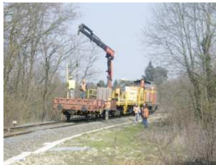
Deux méthodes de matage pour la pose des poteaux
