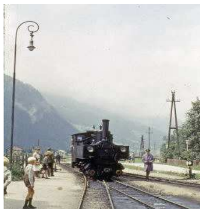
L'AchenseeBahn. Locomotive 020 T Voie métrique à crémaillère type Riggenbach Rampe maximum 160 ‰. Rampe moyenne 130 ‰.
