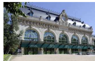
La façade de la gare en septembre 2010
