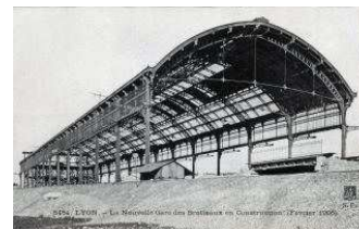
La marquise de la gare en construction
