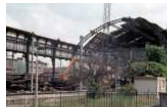
mai 1985 - la marquise vue côté nord.
