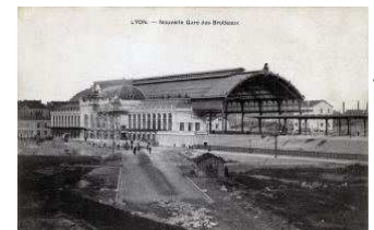
Chantier de la nouvelle gare des Brotteaux
