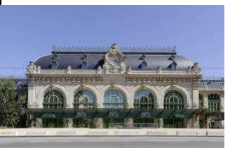
La façade de la gare en septembre 2010
