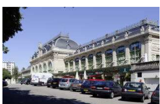
La façade de la gare en septembre 2010
