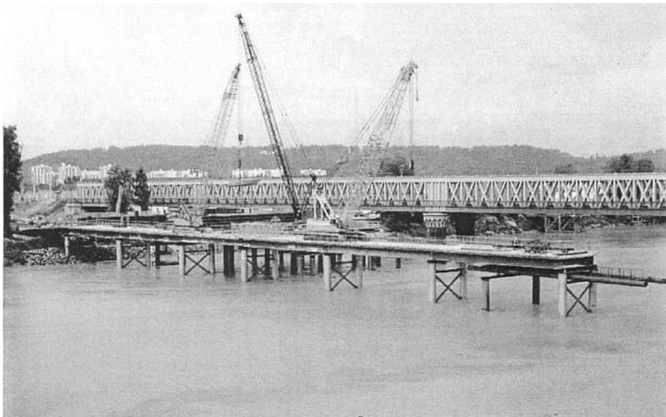
Hiver 2006 : le ponton construit depuis la rive droite pour la réalisation des premières piles.
