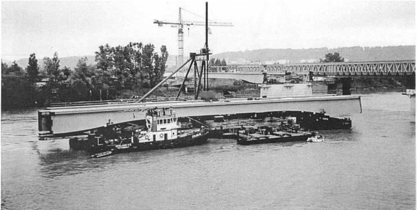
Le 26 Mai, la barge tirée par le remorqueur hollandais est arrimée à la barge SARENS et on fixe la première poutre à la pince du portique de levage.
