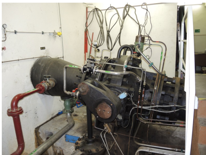
Etage intermédiaire : arrivée des conduites et vannes.
