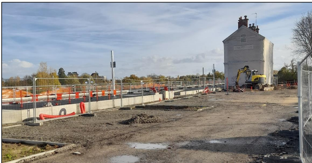
La quai côté BV. Le rehaussement est achevé et la signalétique commence à être installée pour le service de décembre.
