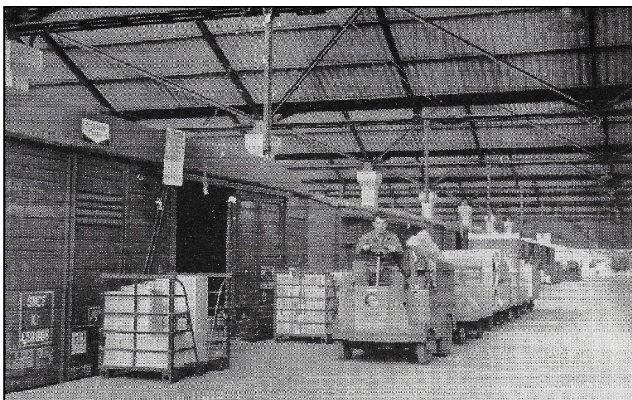
Noria de chariots aux quais de chargements. La hauteur du quai est rigoureusement au niveau du plancher des wagons (DR- collection AFAC-CL)
