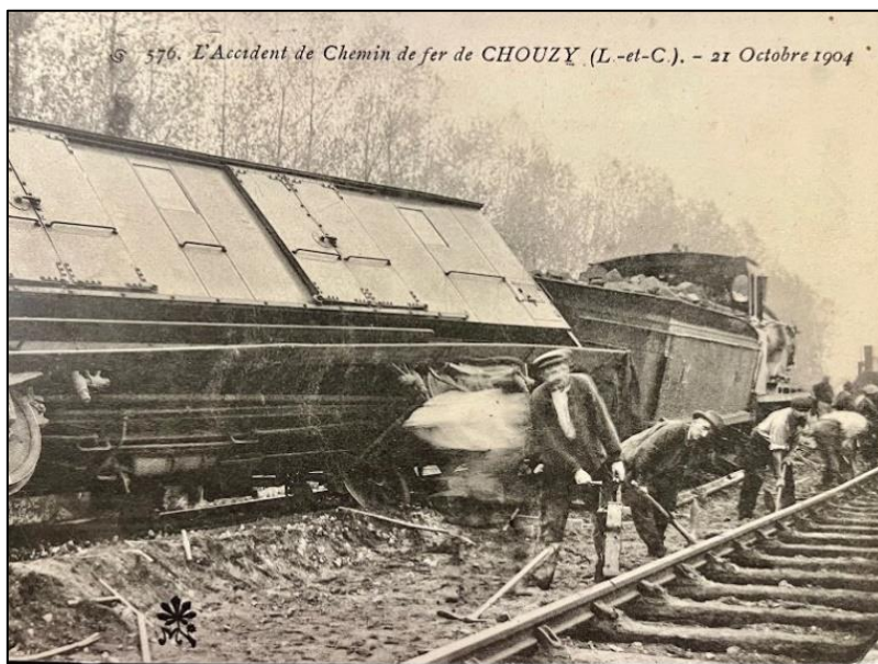
Les ouvriers s'affairent à reprendre la voie 1
