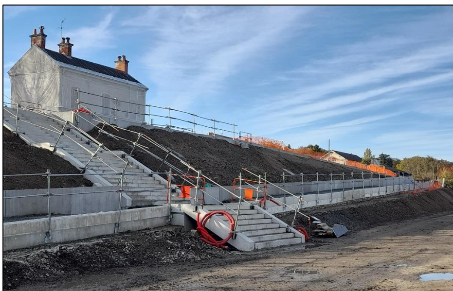
La rampe d'accès du quai direction Tours.
